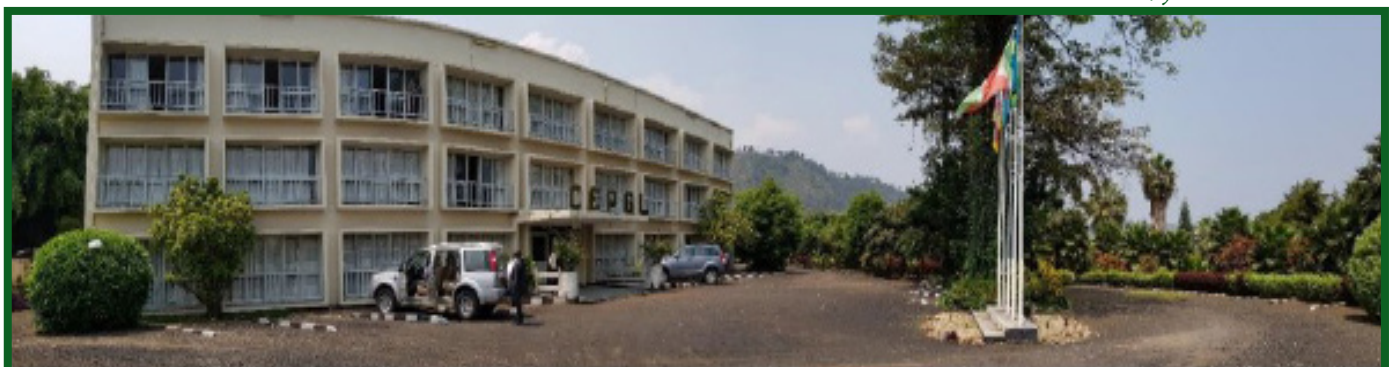
Bureau ABAKIR au bâtiment CEPGL (Communauté Economique des Pays des Grands Lacs) à Rubavu, Rwanda
